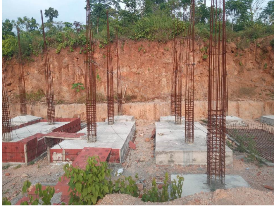
चित्र: अधुरो भवनको निर्माण कार्य
